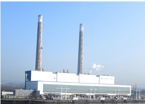
FIGURE 9.27 – Centrale électrique de Porcheville, alimentée au charbon jusqu'en 1987 et fonctionnant désormais au fioul. Elle sert principalement les demandes de pointe.
